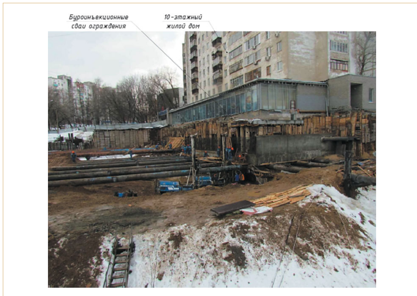
Рис. 1. Котлован и примыкающий к нему десятиэтажный жилой дом
