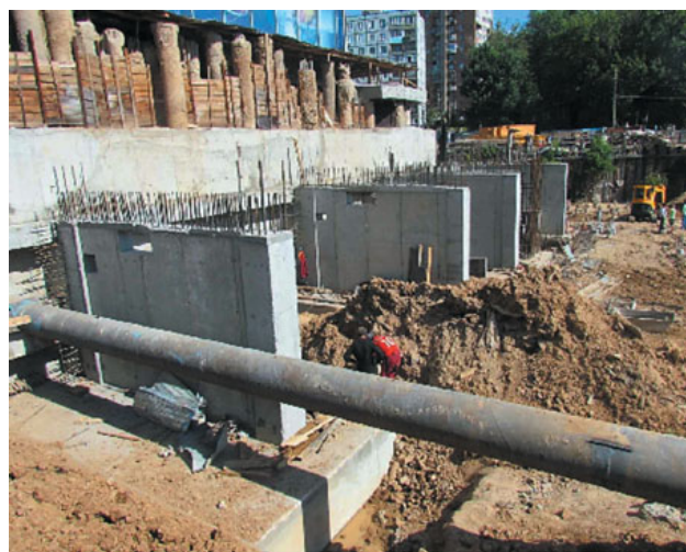
Рис. 4. Фрагменты выполненных контрфорсов
