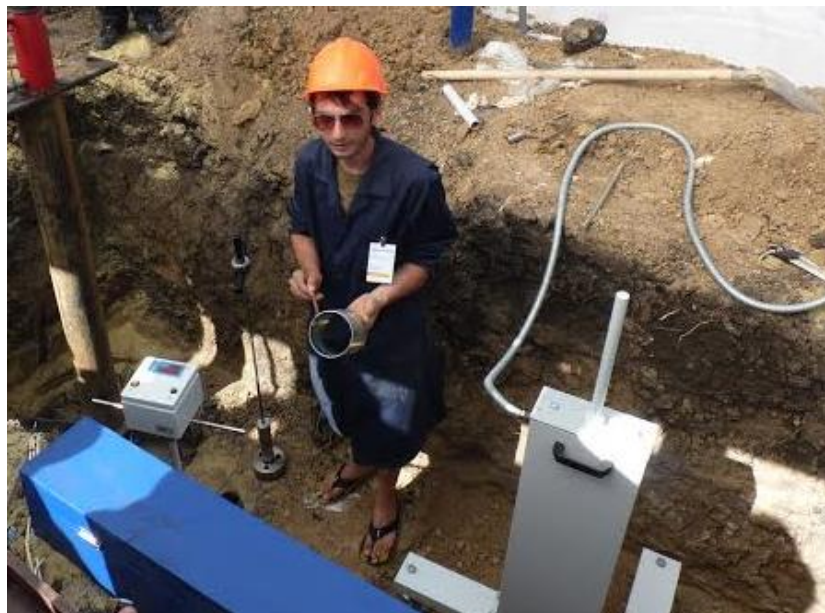
Рис. 8. Испытания грунта в шурфе на полигоне ООО «НПП-Геотек»: 1 – установка для комплексных испытаний грунтов; 2 – пробоотборник; 3 – кольцо пробоотборника; 4 – устройство для испытаний грунтов методом лопастного среза
