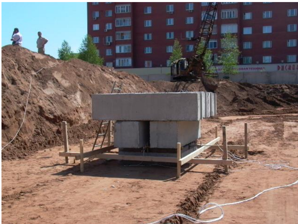
Рис. 8. Нагружение штампа весом фундаментных блоков. Штамп номер 1
