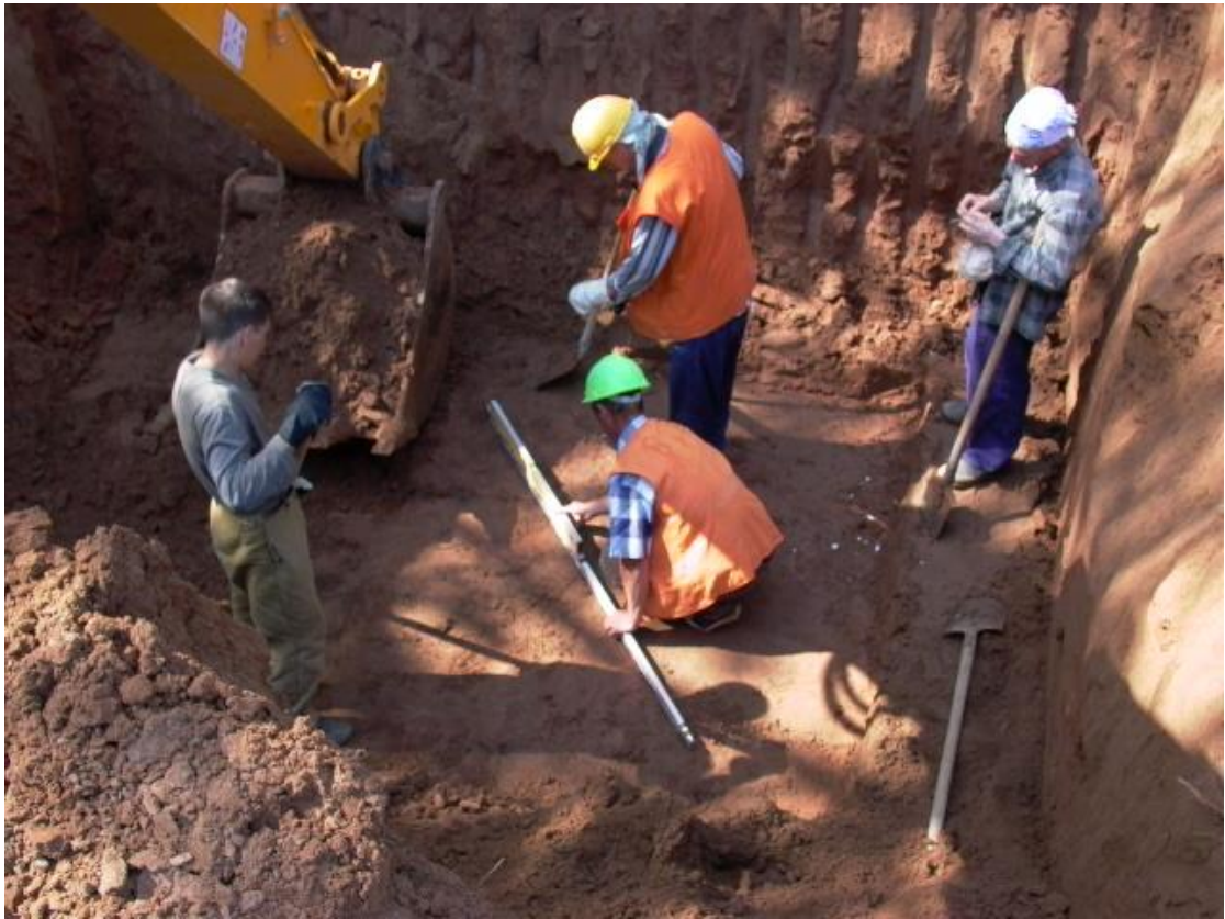
Рис. 11. Подготовка дна выработки перед установкой штампа
